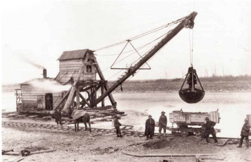
1911 - Kiesgewinnung für Durchstichdämme aus dem Rhein (Greifbagger bei der Schmitterbrücke)
