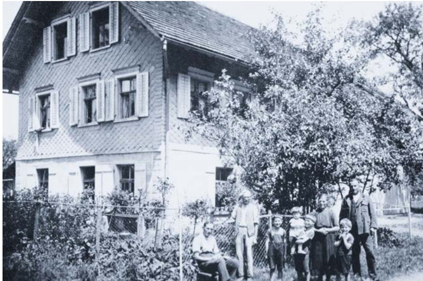
Das Haus der Familie Dr. Franz Häfele wurde im Verlauf der Kampfhandlungen am 2. Mai 1945 zerstört.
