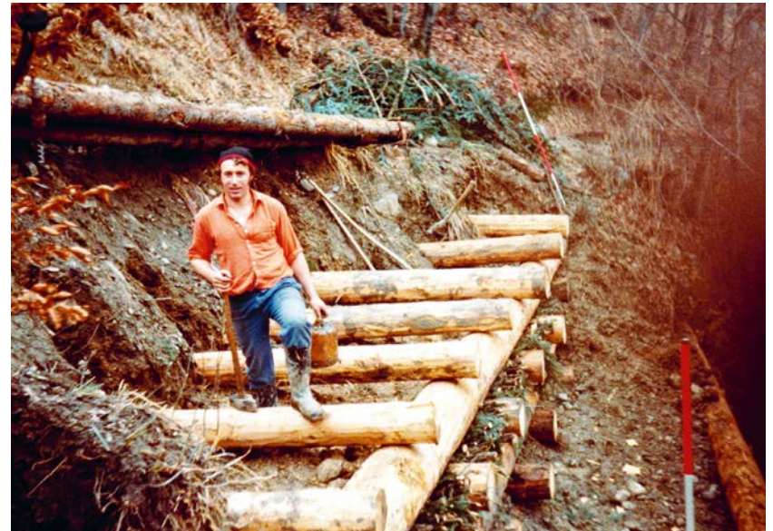
Sanierung des Rohraweges – Finsternau durch Forstarbeiter nach der großen Rutschung 1983.
