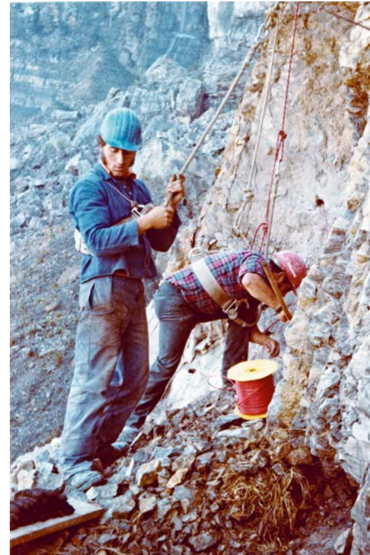
Wiedererrichtung des Leiterweges durch Forstarbeiter (1979)
