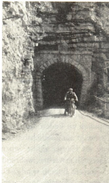
Tunnel an der Laternser Straße
