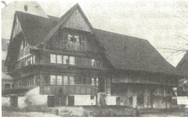
Doppel- giebliges Rheintal- haus in Dornbirn, Riedgasse (1929 durch Brand zerstört)
