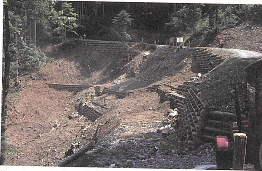
Neuverbauung im Abrutschgebiet am Gsohlweg
