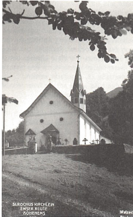
Kapelle, nach der Renovierung im Jahr 1911
