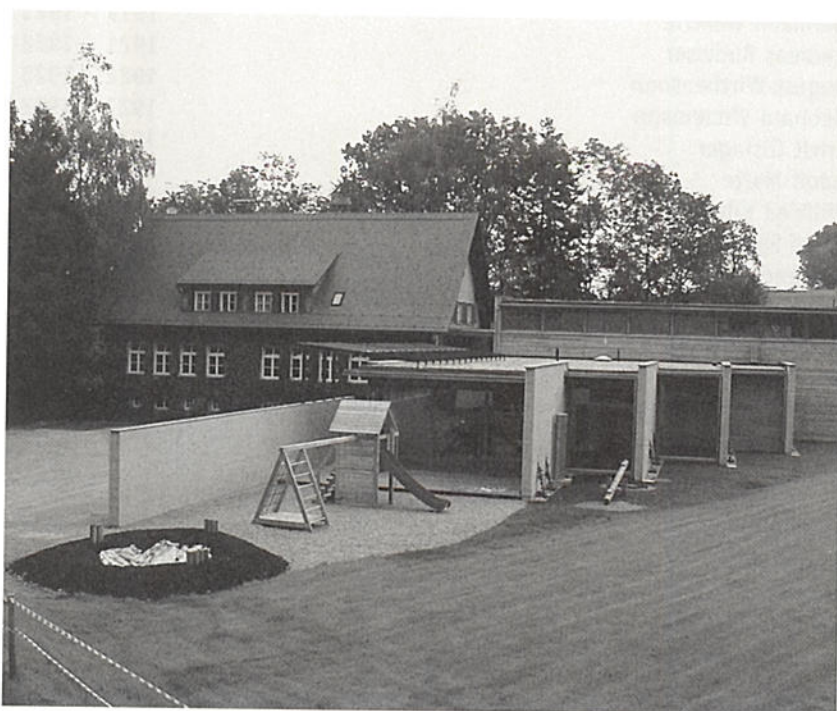
Jetzige Ansicht der Reutener Schule mit Turnhalle und Kindergarten
